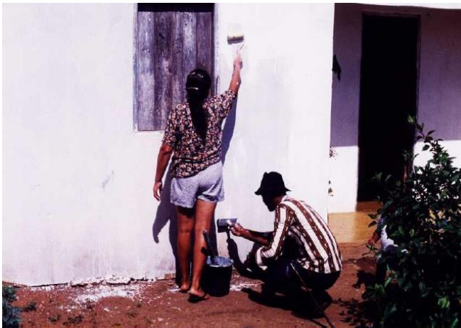
Figura 6 - Pintura de casa com mucilagem de palma associada à cal, Valente, Bahia.
